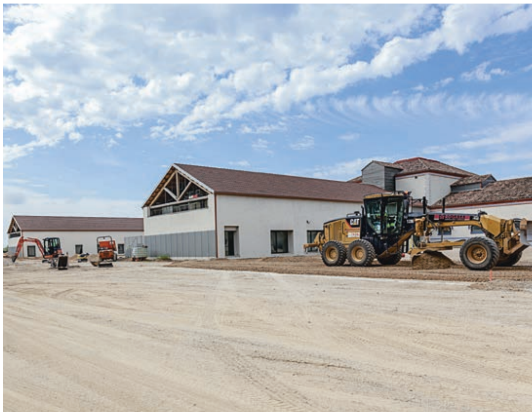
Obras de urbanización del exterior del edificio.
